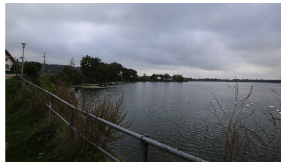
Abb. 43: Blick über den Stausee in Eching
