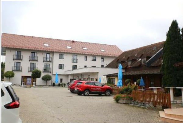
Zusammenspiel von alter und neuer Bausubstanz
